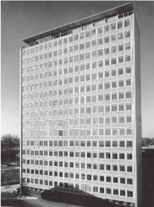
Das 1954 – 56 nach Plänen von Dieter Oesterlen errichtete Okerhochhaus der TU Braunschweig. Foto: Heinrich Heidersberger.
